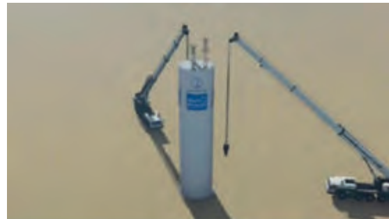
รูปที่ 6 การก่อสร้างท่อปรับแรงดัน
